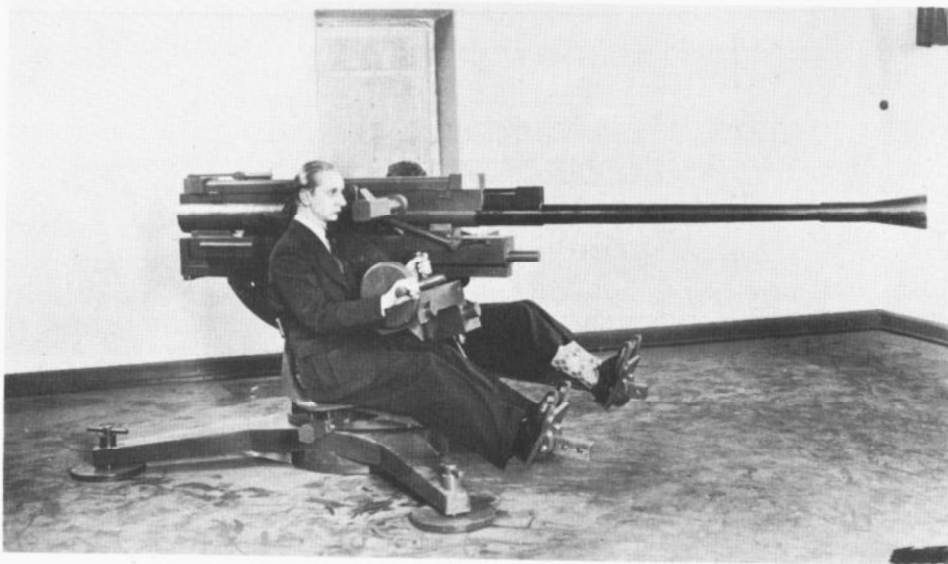
Bild 3: Gerät 339 (Kp), Holzmodell mit 2-Mann-Bedienung
